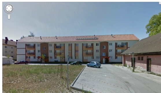
1.14-2 ábra: Petőfi udvar, felújított épület
